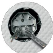
下のハウジング部分を凹型ボックスに押し込む
