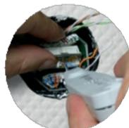
接続ユニットを下部ハウジング部に押し込み、LSA+ツールでバッファーを接続する
