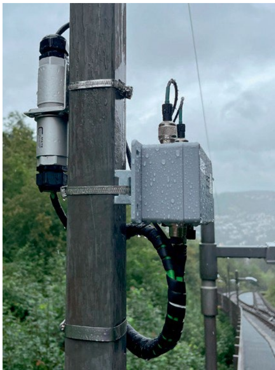
MCO IP69k保護ハウジング付きマストの固定
